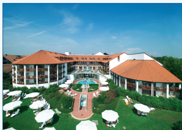
Relaxen in der Sonne – eine der erstklassigen Hotelanlagen in Bad Griesbach
